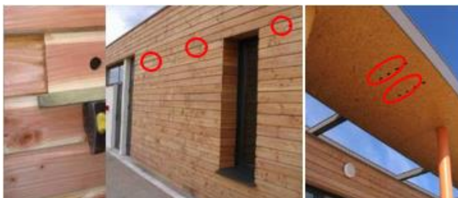
Exemples de nichoirs à oiseaux intégrés dans le bâti (Source : LPO Vienne – T. Dubois)
