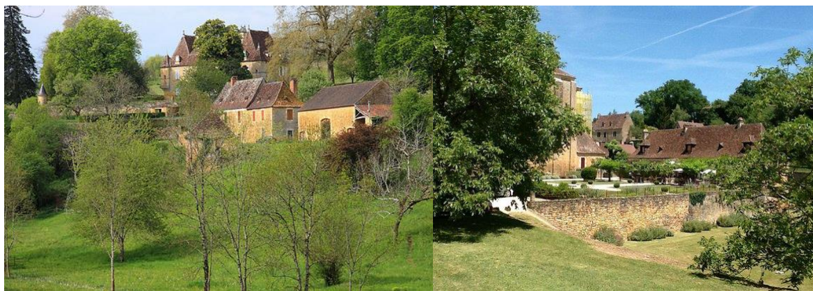
Vues du bourg de Paunat, de son architecture, de ses matériaux, et de des implantations particulières
