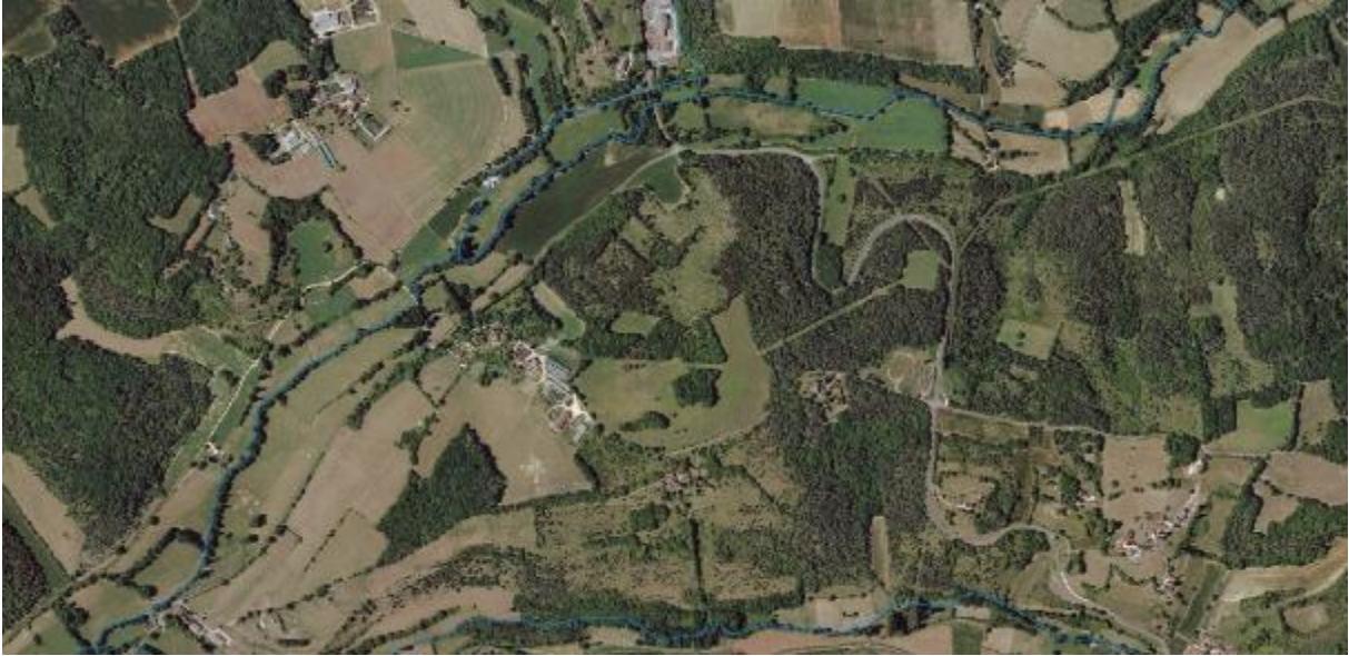
Vallée du Caudeau au niveau de Saint-Laurent-des-Bâtons (source : BDOrtho 2016)
